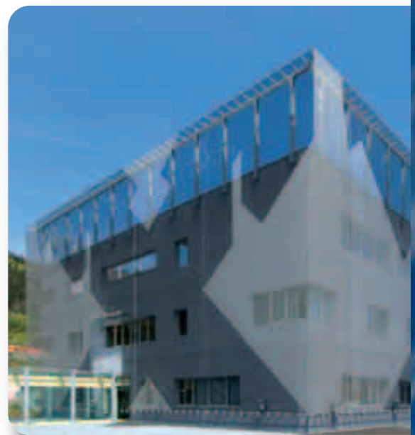
Raika Kompetenzzentrum, Bruck an der Mur/Österreich Architekt: Hans-Jörg Tschom Gewebe: Omega 1540 (Sonderanfertigung) (24)
