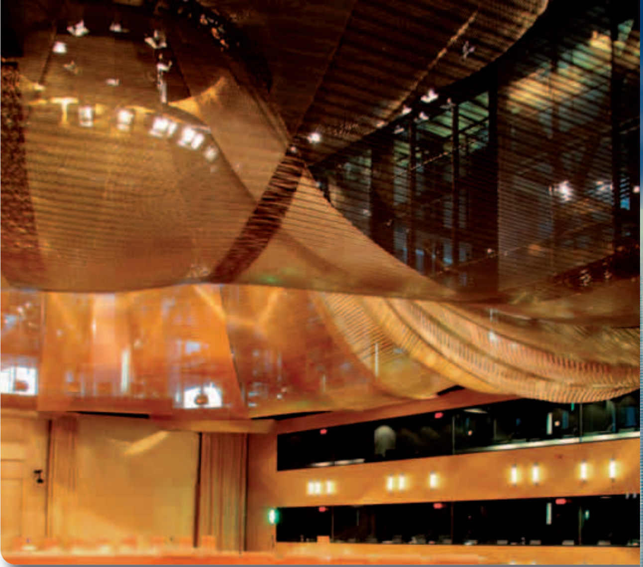
Sitzungssaal Europäischer Gerichtshof, Luxemburg Architekt: Dominique Perrault Architects Gewebe: Escale 5x1 Aluminium, goldfarbig eloxiert (27)
