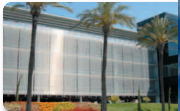
Parkhaus Barcelona Flughafen, Barcelona/Spanien Architekt: Perez Pita Gewebe: Tigris (20)
