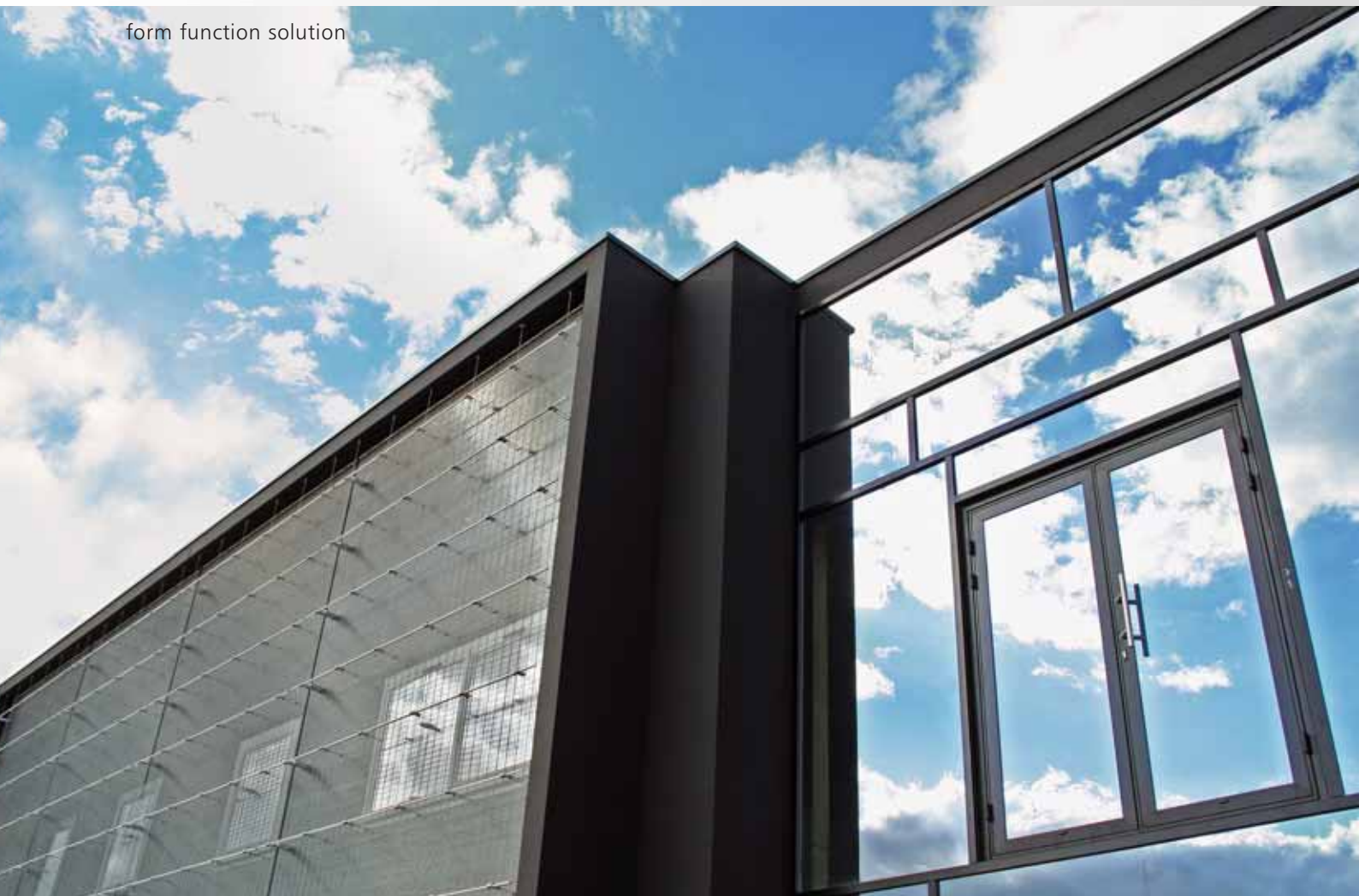
Bürogebäude mit illu mesh®-Fassade in Frankreich
