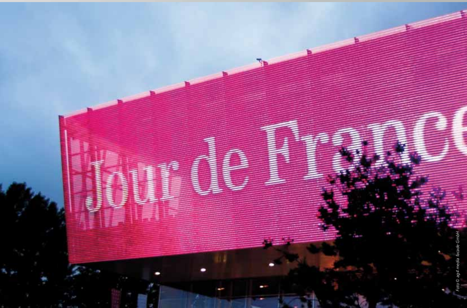
Erste transparente Medienfassade auf Lamellenbasis: Das F-Mobile Headquarters in Bonn/Deutschland
